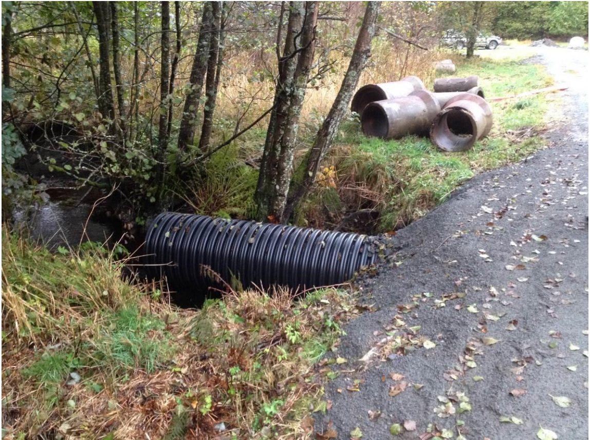
Figur 15. Nytt rør ved utbedring av vegen, jf. figur 5. Passasjemulighet for beitedyr er etablert med overdekking av grove masser etter at bildet ble tatt.
